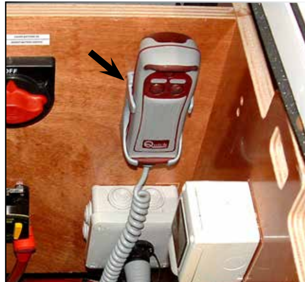
FERNBEDIENUNG DES ELEKTRISCHEN ANKERSPILLS
