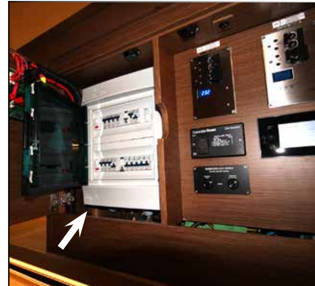
SCHUTZSCHALTER DER VERBRAUCHER
