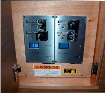
SCHALTAFELN STROMAUSWAHL 110 V-/ 220 V
