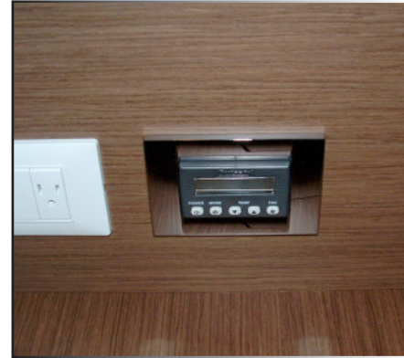
BEDIENUNG DER KLIMAANLAGE
