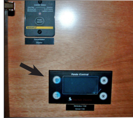
BEDIENUNG ZUM ANLASSEN DES GENERATORS
