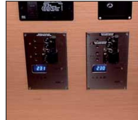
SCHALTTAFELN STROMAUSWAHL 110 V-/220 V
