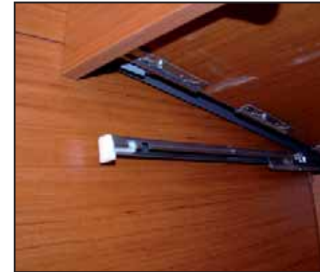
AUSBAU EINER SCHUBLADE: HEBEL + FÜHRUNGSSCHIENE
