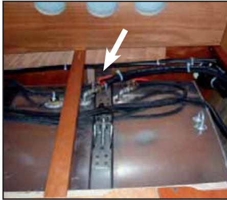
TANK + KRAFTSTOFF- VERSORGUNGSVENTIL
