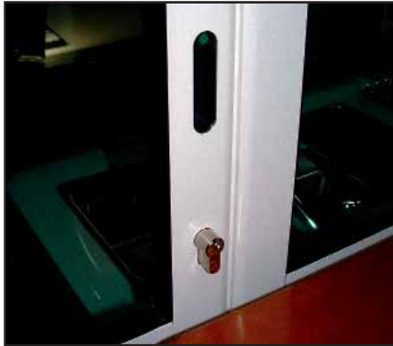
VERRIEGELUNG DER SCHIEBETÜR
